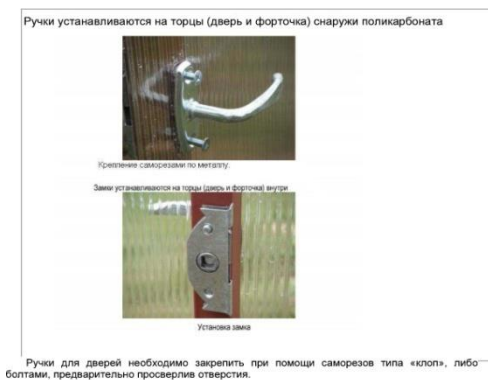
Рис.6. Установка замка
